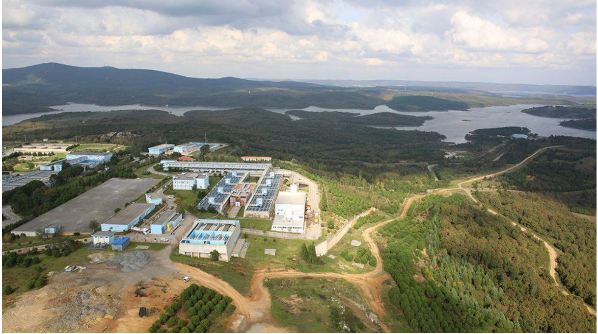
Şekil 15. Ömerli İçme Suyu Arıtma Tesisi 22
