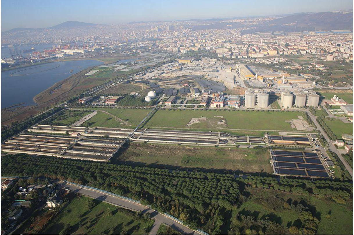
Şekil 16. İSKİ Tuzla İleri Biyolojik Atıksu Arıtma Tesisi
